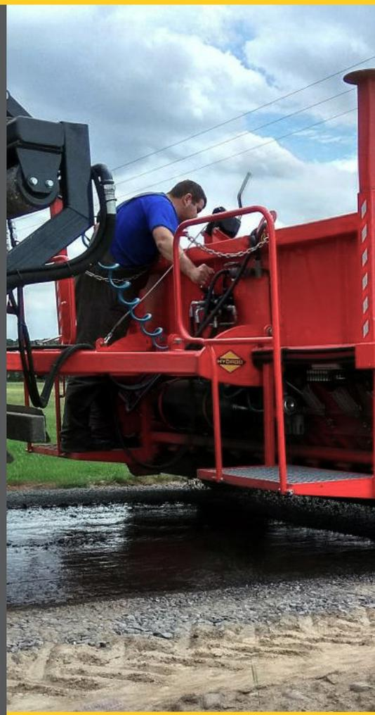
El esparcidor de árido **HYDROG RPU-3000 / RPU-3500** es un equipo fiable para el sellado superficial de carreteras, que en combinación con un distribuidor de emulsión bituminosa forma un conjunto completo para reparaciones duraderas y económicas del pavimento. Gracias al suministro continuo de árido desde la caja de un volquete, el trabajo se realiza sin interrupciones frecuentes, lo que incrementa considerablemente la eficiencia.
