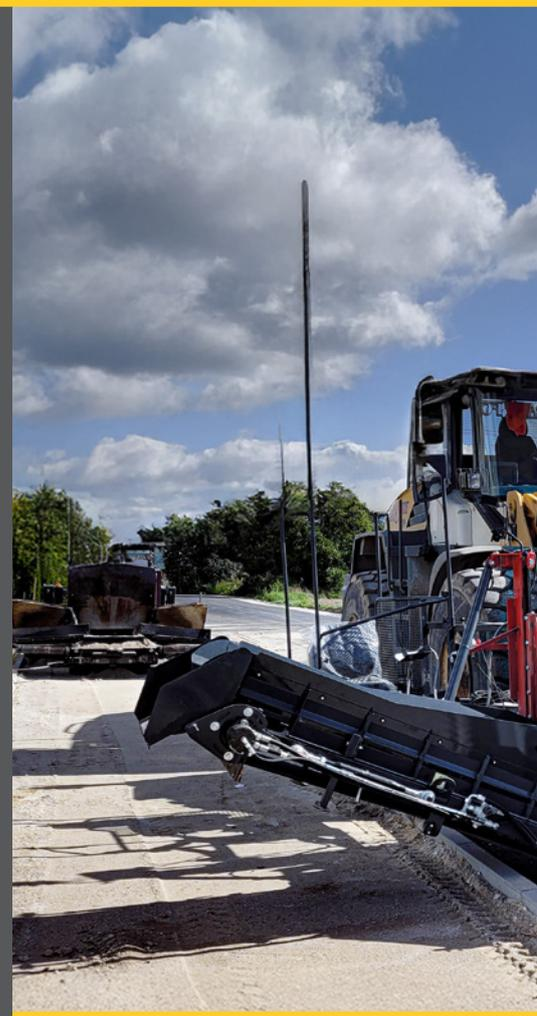
La extendidora de arcenes **HYDROG DG-3000 PREMIUM** es una solución fiable para la colocación eficiente de arcenes y ampliaciones de calzada. Gracias a su capacidad para trabajar con áridos de carretera y mezcla asfáltica caliente, esta máquina es perfecta para diversos proyectos viales, garantizando precisión y durabilidad.
