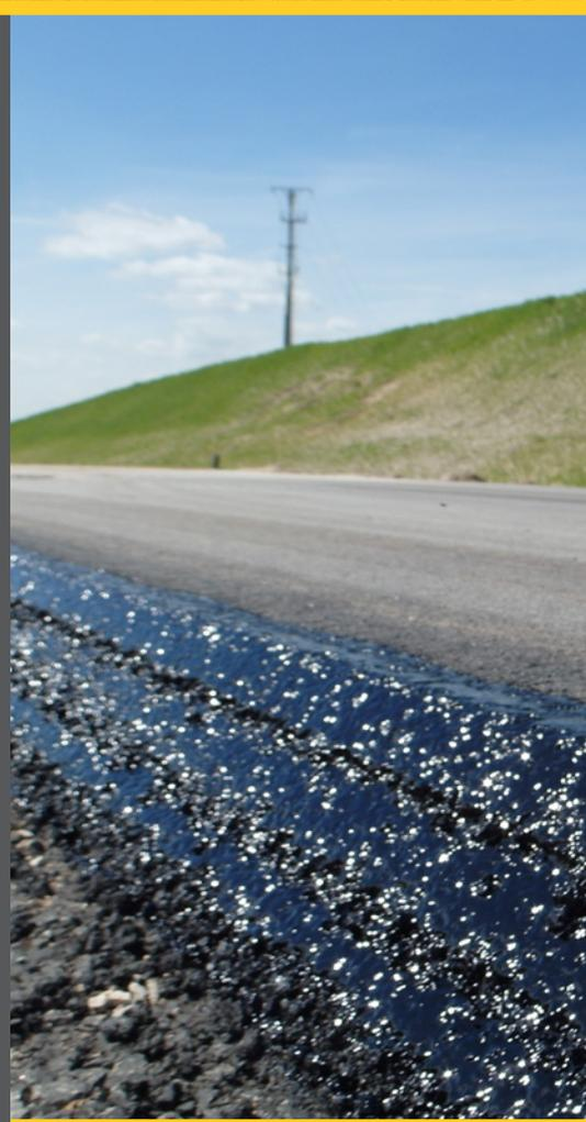
La **HYDROG SA-3000** est une arroseuse – couleuse d'asphalte professionnelle qui garantit la durabilité et l'étanchéité des revêtements routiers. Sa fonction principale est de pulvériser de l'asphalte chaud sur les bords de la chaussée, ce qui permet de fermer efficacement la structure poreuse du bord en enrobé bitumineux et d'empêcher la pénétration de l'eau et la détérioration prématurée de la route.
